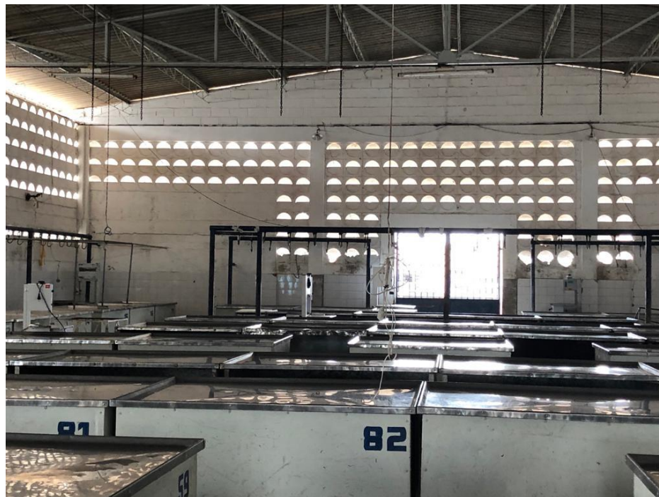
Foto 1: Vista da parte interna do Mercado Municipal.
